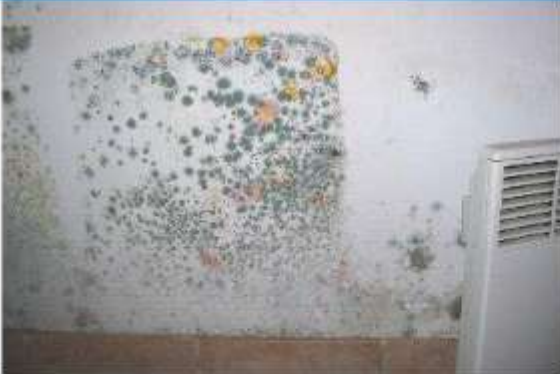
Contaminations fongiques sur un mur
